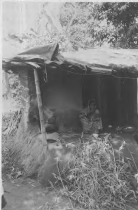
Ein Zyklon hat das Strohdach weggerissen. Die alte Plastikplane bietet wenig Schutz vor den Einflüssen der Witterung.
